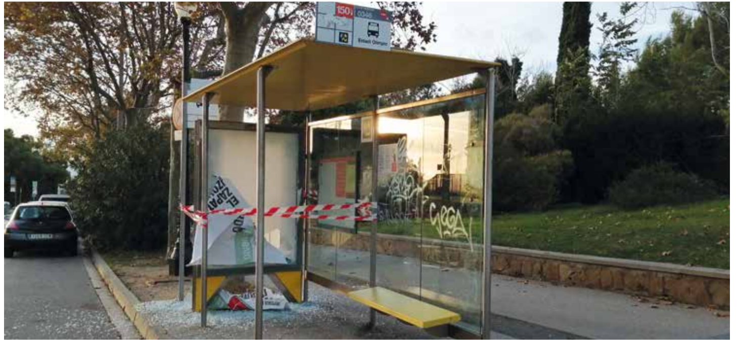
► Una de les marquesines de Montjuïc.
